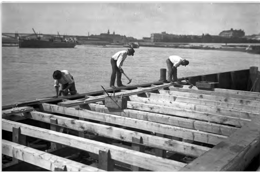
Шупери раде на броду са кесер-теслом, Сегедин, 1908. Из фото-збирке Музеја „Ференц Мора” (инв. бр. mfm_n00120)
