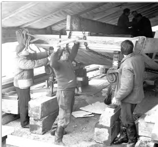
Посувраћивање носа дереглије, МАХАРТ – Тапе (снимак Антала Јухаса, 1971). Из фото-збирке Музеја „Ференц Мора“ (инв. бр. mfm_n18210)
