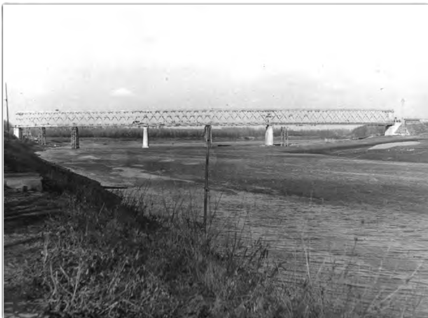
Épülőfélben az új vashíd 1963 elején (Történelmi Levéltár, Zenta)
